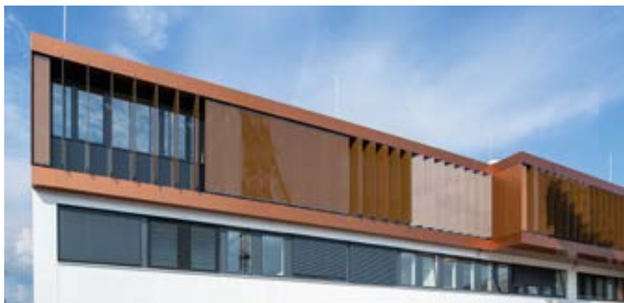
NO-Ansicht der RHZ Bau GmbH: die manuelle Steuerbarkeit der Lamellen zeigt sich an der Fassade
