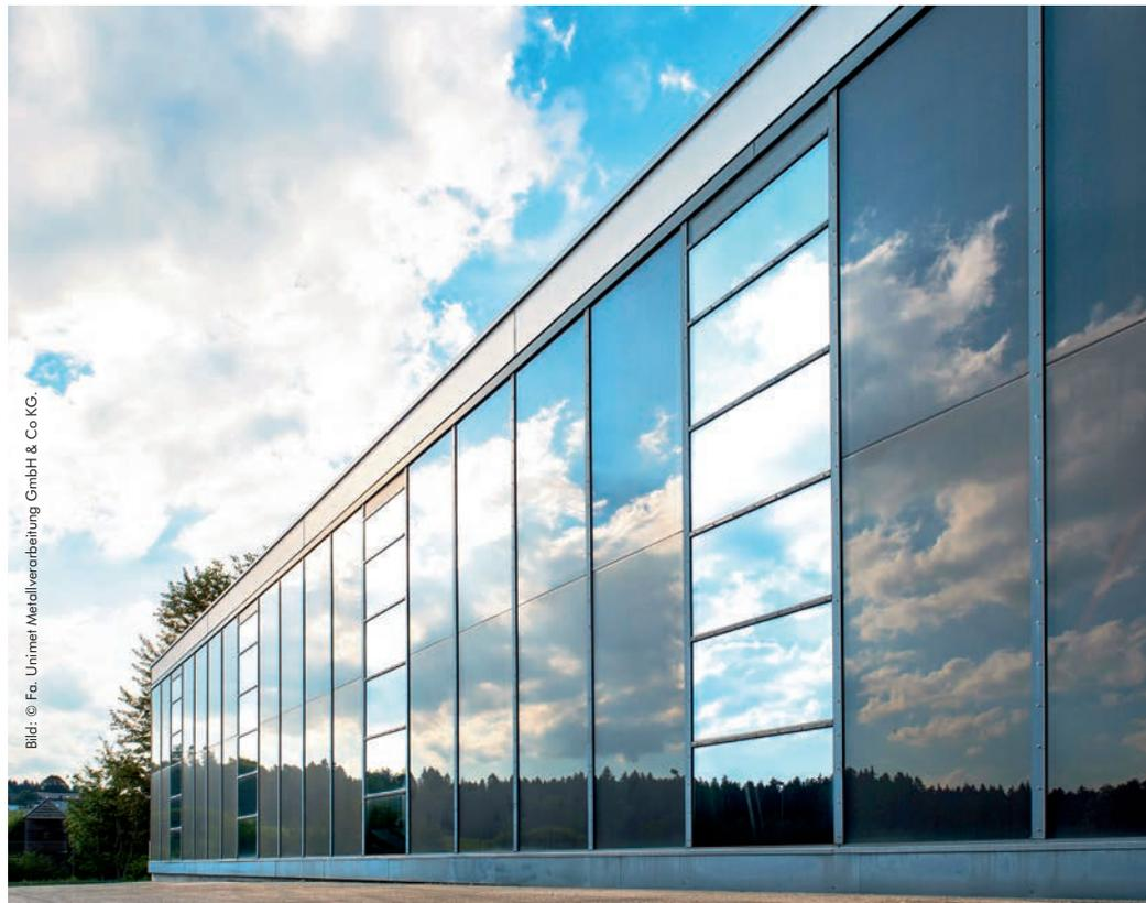
1 | Unipower Pro – Pfosten-Riegel-Fassade mit integrierten und gebäudehohen thermischen Kollektoren im Wechsel mit Tageslichtflächen von Unimet.
