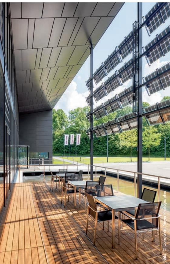
3| PV-Lamellenfassade, sonnenstandgeführt, am DGNB Platin zertifizierten Schulungsgebäude von Stiebel Eltron. Kombi aus Sonnenschutz und Energieerzeugung.
