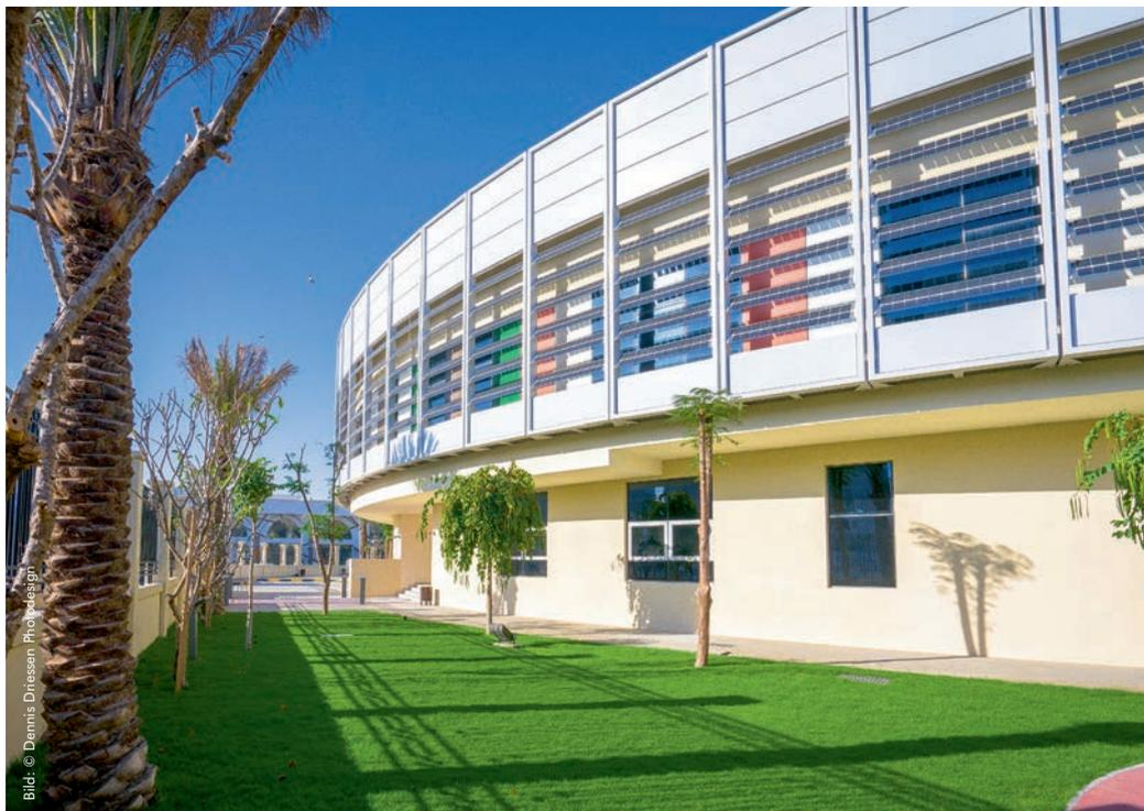
6 | PV-Lamellen Sonderlösung: Eingebettet im bogenförmigen „Schild“ bewegen sich die angewinkelten Spezialmodule von Ost nach West azimuthal ums kreisförmige Gebäude der Tarek Ibn Ziad School in Doha.
