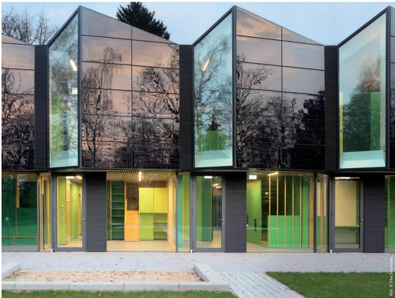
7 | e+ Kita Marburg. Hinterlüftete Fassade in kristalliner Technik mit großformatigen Modulen von Ertex Solar. Symbiose aus markanter Architektursprache und Energiewandlung in der Fassade. Opus Architekten.
