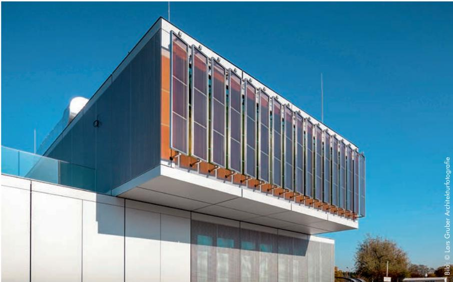
8 | Organische Photovoltaik (OPV) eingebunden in das Shadovoltaic System von Colt International am Innovationszentrum von Merck in Darmstadt. OPV ist in verschiedenen Farben herstellbar.
